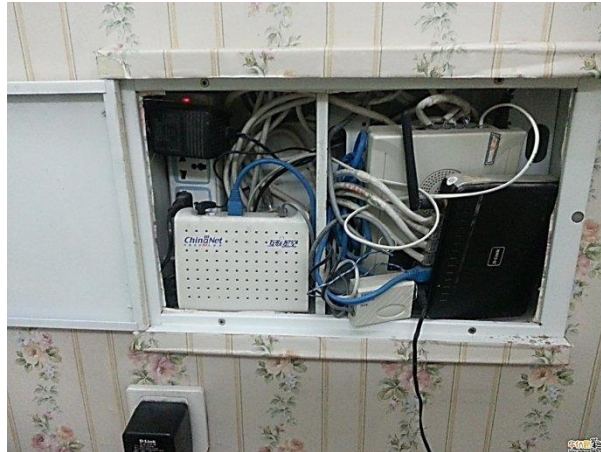
图2-2 Wi-Fi 网关放置在金属板的信息箱内示意图
